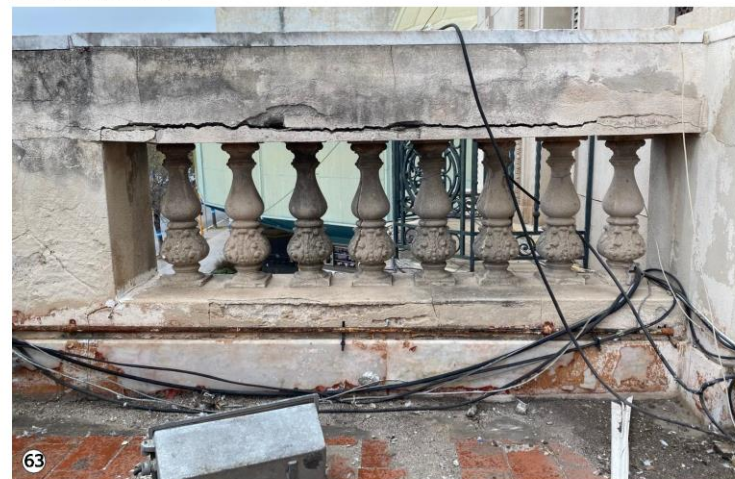
63 Grieta horizontal en tramo superior de balastrada. Erosión en material en muros produce desprendimiento de revoques y pinturas.
