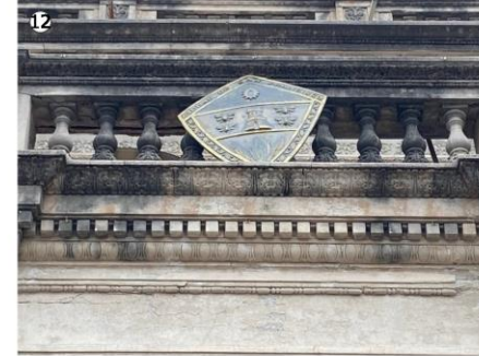
Presencia de pátina biológica en tramo de balaustrada (hollín, costra negra).
