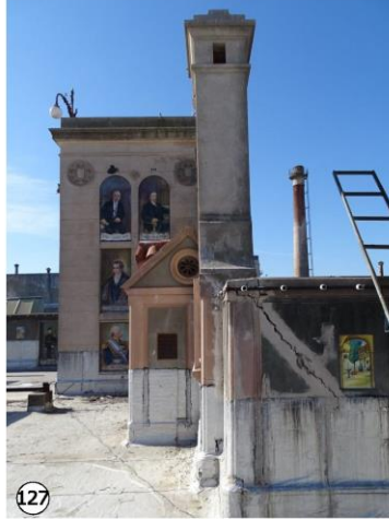
Grieta diagonal en muro perimetral de cubierta.
