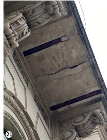
21 Ménsulas de hierro que conforman la estructura de soporte del balcón, en estado de oxidación y en contacto con el agua de lluvia.
