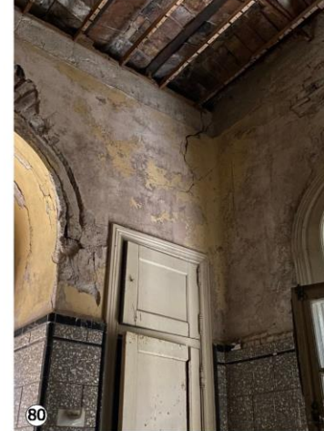
Baño en avanzado estado de Deterioro: Grieta en arco de muro sobre ventana, y en esquina superior de baño. Desprendimiento de material de paredes y cielorrasos.
