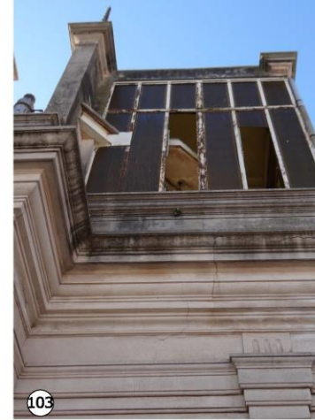
103 Grietas y Fisuras en tramo superior de muro exterior y cornisa
