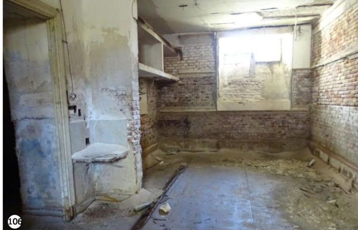
106 Consecuencia del alto nivel de la capa freática y la constante presencia de agua en el subsuelo, se produce el desprendimiento de material correspondiente a revoques y pinturas, estado de oxidación de los hierros que conforman la estructura, presencia de sales por eflorescencia en muros.
