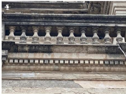
Presencia de pátina biológica en tramo de balaustrada (hollín, costra negra). Erosión y desprendimiento de material en base de apoyo de balaustres.
