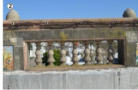
Pátina biológica (musgo, hollín) Presencia de fisuras en tramo superior balaustres (parapeto)
