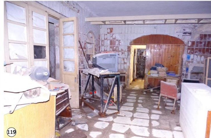
Presencia de humedades en muros y pisos, consecuencia de la constante presencia de agua produce el deterioro de aberturas de madera, materiales de revestimiento, desprendimiento y erosión de revocos.
