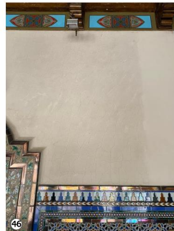
46 Mapeo de pared: Abundante presencia de micro-suras en muro.
