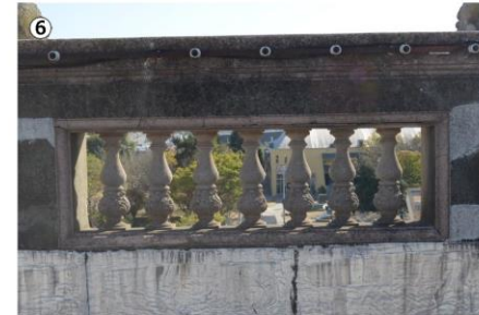
Presencia de fisuras en base y tramo superior de balaustres (parapeto).
