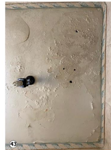
43 Considerable estado de desprendimiento de material en cielorraso, consecuencia de la presencia de humedades.
