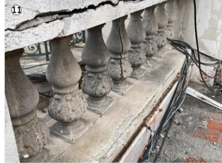
Grieta vertical en balaustres posibilita el ingreso del agua de lluvia hacia el interior, aumentando el estado de deterioro y patologías de las piezas ornamentales.
