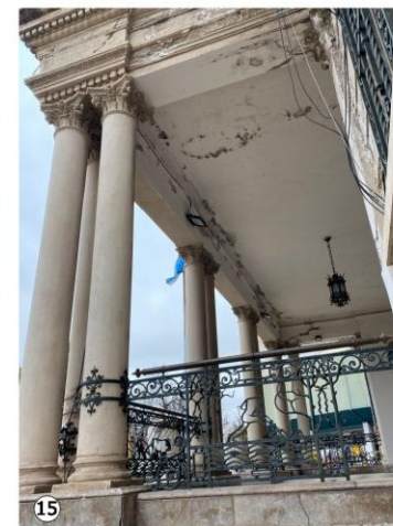
15 Humedades y desprendimiento de material en cielorraso de ingreso, consecuencia de la falta de impermeabilización de la terraza superior.
