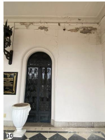
10 Grieta vertical en lateral derecho de abertura. Desprendimiento de material en tramo superior de muro.
