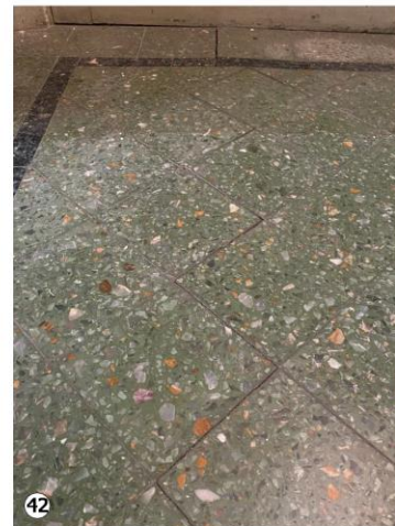
42 Desnivel en piso de baño produce rotura de juntas y desprendimiento de mosaicos.
