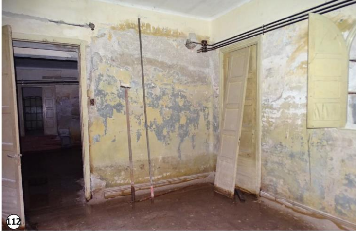
Consecuencia del alto nivel de la capa freática y la constante presencia de agua en el subsuelo, se produce el desprendimiento de material correspondiente a revoques y pinturas, presencia de sales por e-orecencia en muros y cielorrasos.
