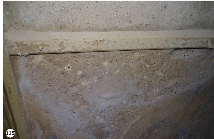
Abundante presencia de sales por e-orecencia en revoques y pinturas de muros.
