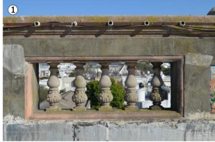
Tramo de balaustre con presencia de pátina biológica (musgo, hollín) Presencia de fisuras en tramo superior balaustres (parapeto)
