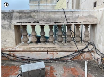
Grieta horizontal en parapeto, con riesgo inminente de caída de material. Erosión y desprendimiento de material en base de apoyo de balaustrada.
