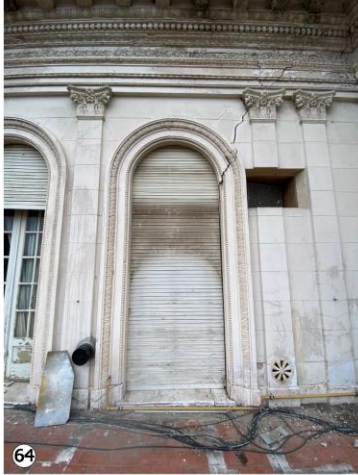
Grietas diagonales en muros de considerable separación.
