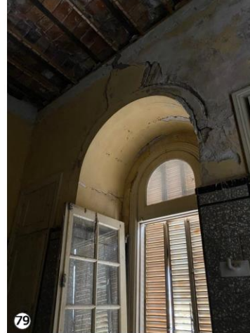
Baño en avanzado estado de Deterioro: Grieta en arco de muro sobre ventana, y en esquina superior de baño. Desprendimiento de material de paredes y cielorrasos.
