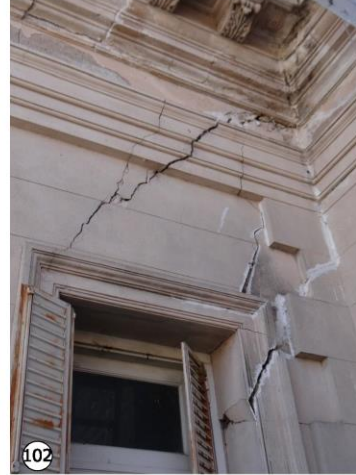
102 Considerables grietas diagonales sobre puerta de salida a terraza posibilita el ingreso de agua hacia el interior, incrementando el deterioro del muro.
