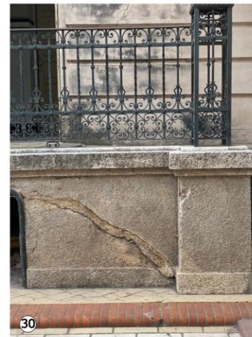
Grieta diagonal en zócalo de fachada (muro de contención de escaleras).
