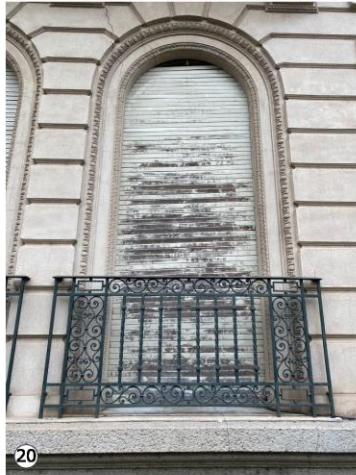
20 Desprendimiento de persianas de madera que protegen las aberturas de la fachada.
