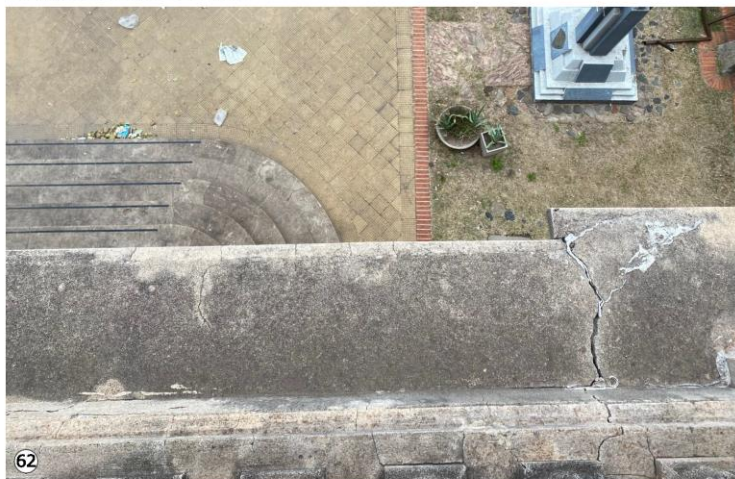
62 Tapa superior de cornisa: Rotura y presencia de fisuras posibilitan el ingreso del agua de lluvia al interior de la estructura.
