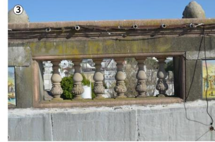
Pátina biológica (musgo, hollín) Presencia de fisuras en tapa de parapeto.
