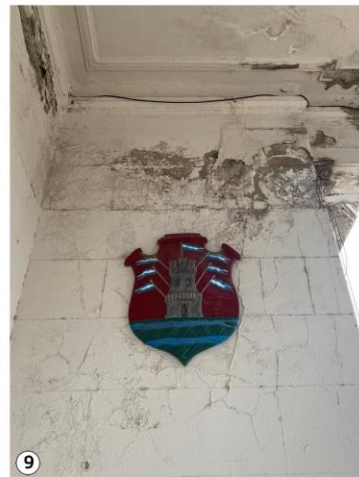
9 Micro-suras, sales por e-orescencia y desprendimiento de material en tramo superior de muro.
