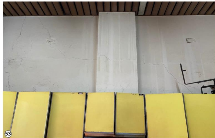
53 Abundante presencia de grietas diagonales en paredes de cocina.
