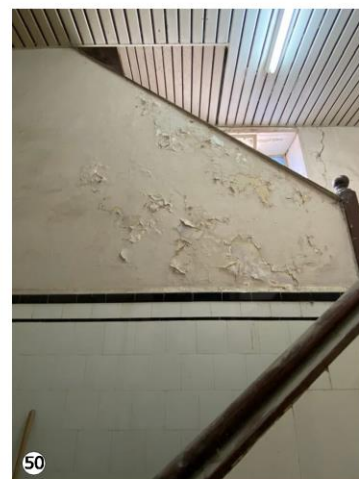
Desprendimiento de material en pared lateral de escalera.
