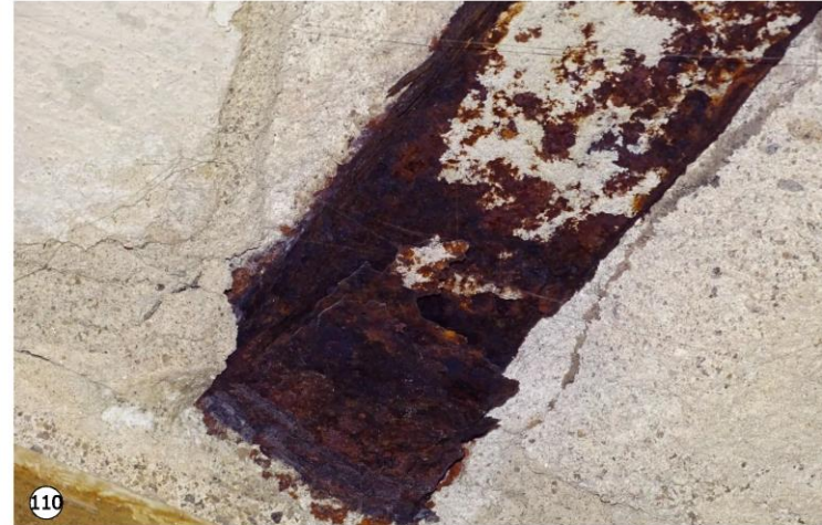
109 Avanzado estado de oxidación ferrosa y decapamiento (pérdida de sección) de los perfiles metálicos que conforman la estructura del subsuelo. Desprendimiento y estado de oxidación del metal desplegado que se encuentra en el cielorraso del subsuelo.
