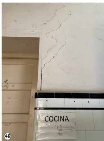
48 Grietas en pasillo hacia cocina de edificio (Planta Baja): Considerables separaciones entre tramos de muro.
