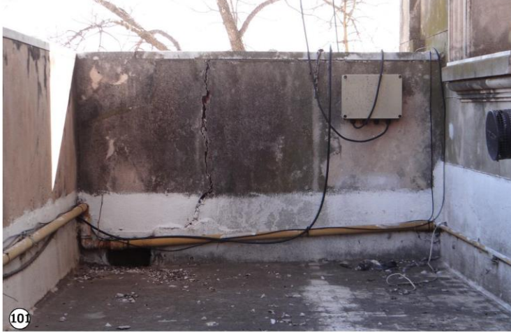
101 Grieta vertical en muro bajo de terraza accesible
