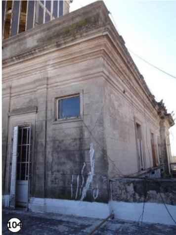
104 Considerables Grietas Diagonales en muros de terraza con antiguas reparaciones. En ambas fotografías se observa como las grietas continúan activas, dado que las mismas volvieron a abrirse posterior a su reparación.
