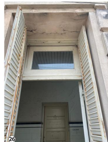
Fisuras y desprendimiento de material en dintel de abertura.
