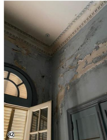
Desprendimiento de material correspondiente a revocos y pinturas de cielorrasos y paredes. Sales por eflorescencia consecuencia de la constante presencia de humedades.
