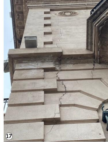
17 Grieta vertical en esquina de muro (sobre calle Echeverría) , desde zócalo de planta baja hasta molduras ornamentales de planta alta.
