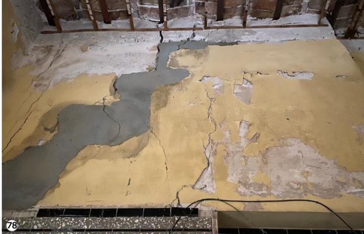
Abundante presencia de grietas en muros de baño en planta alta.
