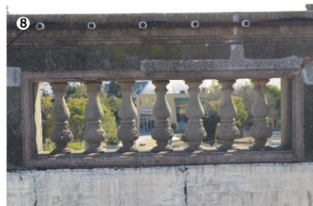
Grieta en balaustre con riesgo de desprendimiento y caída de material
