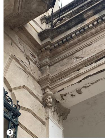
3 Sales por eforescencia consecuencia de la infiltración del agua de lluvia y desprendimiento de material en encuentro de muros.
