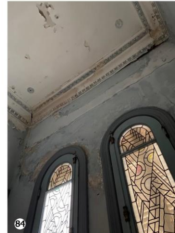
Baño en avanzado estado de Deterioro: Grieta en arco de muro sobre ventana, y en esquina superior de baño. Desprendimiento de material de paredes y cielorrasos.
