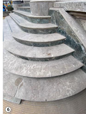
6 Rotura en huellas y contrahuellas de la escalera de acceso principal
