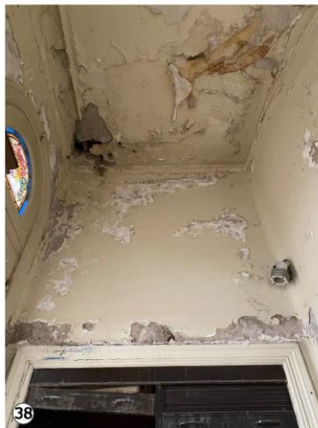
38 Considerable estado de desprendimiento de revoques y pinturas en muros y cielorraso de sala.
