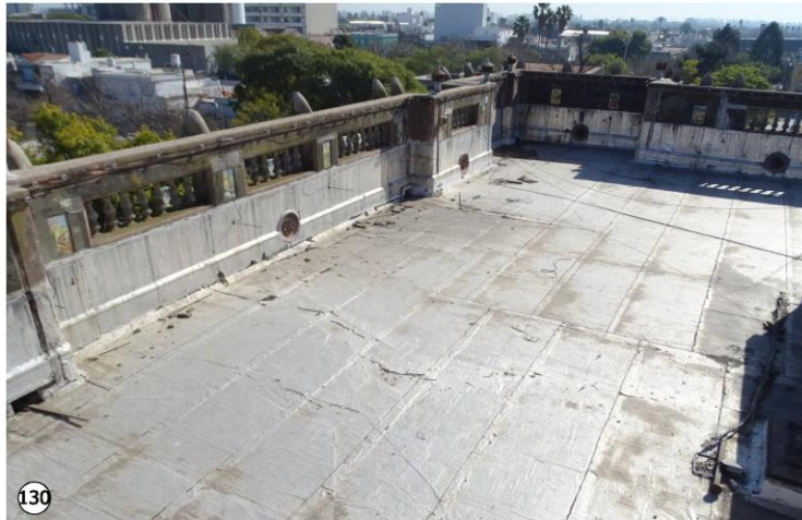
Membrana asfáltica que actúa como elemento de aislación hidrófuga del techo, a la intemperie. Presencia de suciedades, guano de paloma, elementos ajenos a la cubierta (cableado, elementos metálicos sueltos)
