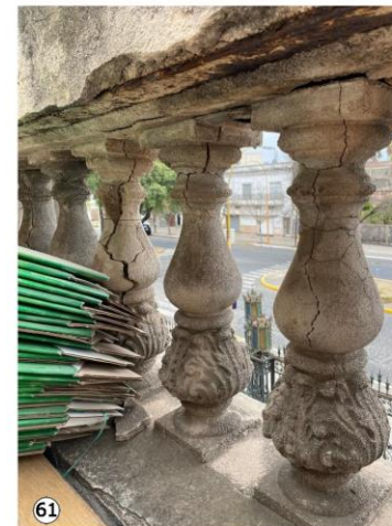
61 Rotura y desprendimiento de balaustres: Riesgo de caída de material sobre el ingreso al edificio.
