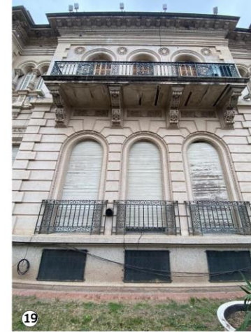
19 Cara inferior de balcón: Estado de corrosión de las ménsulas de hierro que se encuentran expuestas.
