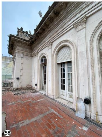
58 Terraza sobre calle 9 de Julio: Inadecuada impermeabilización del piso produce infiltración del agua de lluvia hacia el interior.
