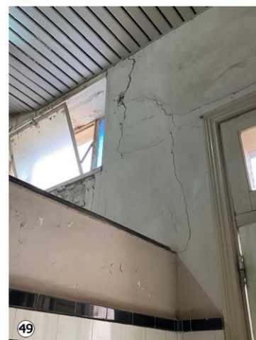
48 Grietas en pasillo hacia cocina de edificio (Planta Baja): Considerables separaciones entre tramos de muro.
