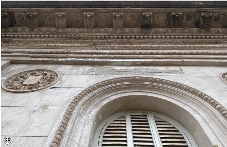
Abundante presencia de sales por eórosencia en cara exterior de muro. Fisuras y desprendimiento de revoque simil piedra.
