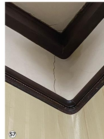
57 Grieta vertical en esquina superior de salón.
