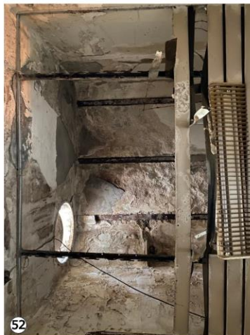
52 Desprendimiento de material en cielorraso y estructura de hierro de losa en estado de oxidación.
