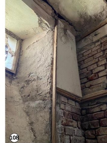
108 Erosión y sales por eflorescencia consecuencia de la constante presencia de agua.
