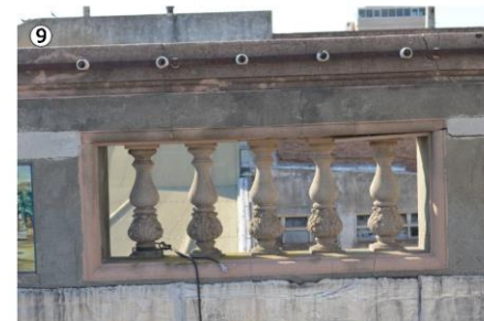
Presencia de fisuras en base y tramo superior balaustres (parapeto)
