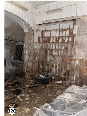
Presencia de humedades en muros y pisos, consecuencia de la constante presencia de agua produce el deterioro de aberturas de madera, materiales de revestimiento, desprendimiento y erosión de revocos.
