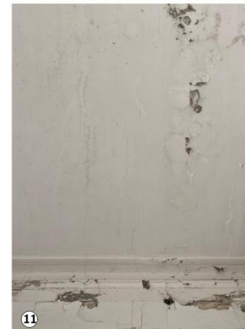
11 Fisuras en cielorraso de ingreso. Presencia de humedades por in-iltración de agua desde terraza.
