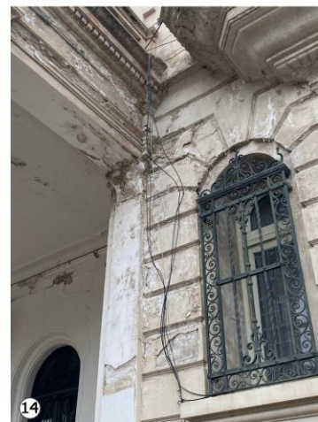
14 Abundante presencia de sales por e-orescencia, Fisuras y desprendimiento de material en muro.
