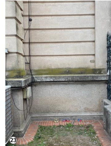
23 Presencia de pátina biológica (musgo, hollín) en zócalo inferior.
