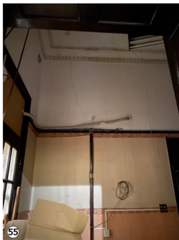
55 Presencia de grietas verticales en muro.
