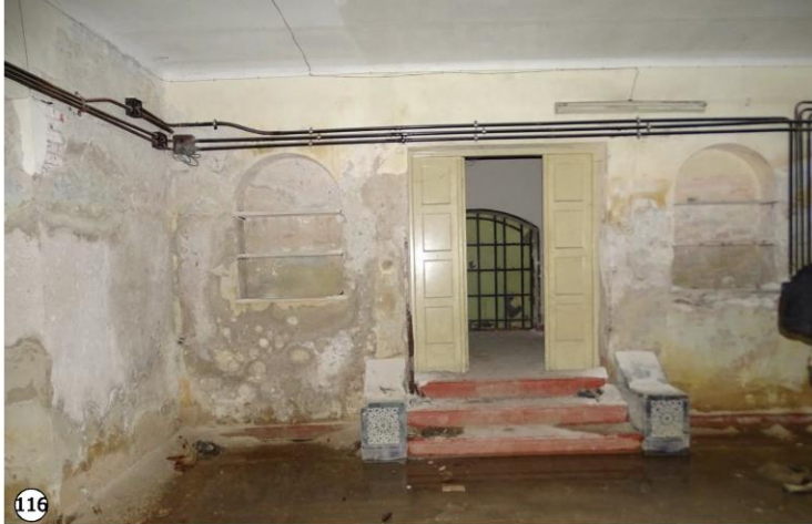
Permanente presencia de agua en superficie de piso, consecuencia del alto nivel de napas freáticas. Desprendimiento de material correspondiente a revocos y pinturas de muros y cielorrasos. Abundante presencia de sales por eflorescencia.
