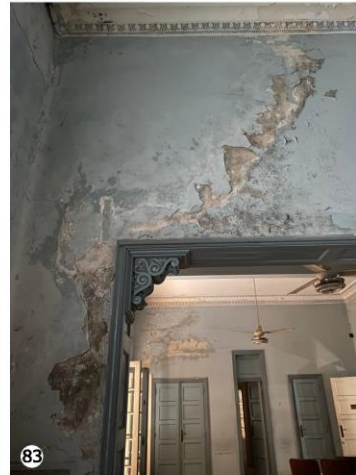
Desprendimiento de material correspondiente a revocos y pinturas de cielorrasos y paredes. Sales por eflorescencia consecuencia de la constante presencia de humedades.
