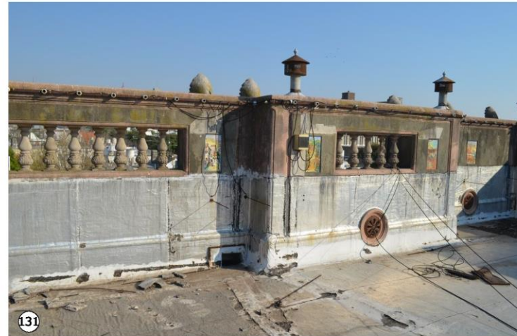
Tramos de la membrana asfáltica (aislación hidrófuga del techo) en estado de rotura, lo que posibilita el ingreso del agua de lluvia hacia el interior de la edificación. Presencia de patina biológica (musgo, hollín) en muros de parapeto.
