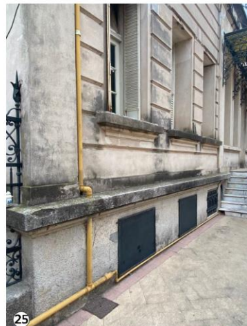
Pátina biológica y costra negra en molduras, salientes de muro, antepechos de aberturas.
