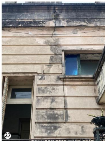
Considerable grieta vertical en muro.
