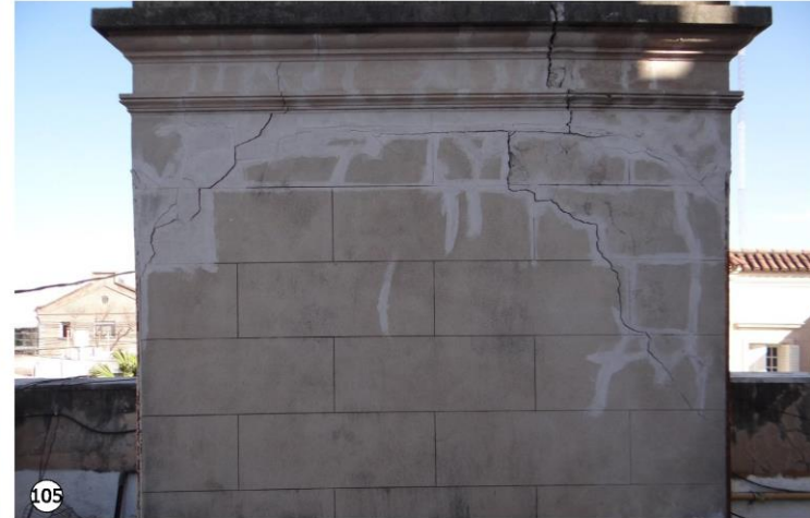
104 Considerables Grietas Diagonales en muros de terraza con antiguas reparaciones. En ambas fotografías se observa como las grietas continúan activas, dado que las mismas volvieron a abrirse posterior a su reparación.
