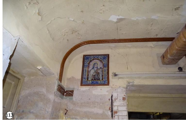
Consecuencia del alto nivel de la capa freática y la constante presencia de agua en el subsuelo, se produce el desprendimiento de material correspondiente a revoques y pinturas, presencia de sales por e-orecencia en muros y cielorrasos.
