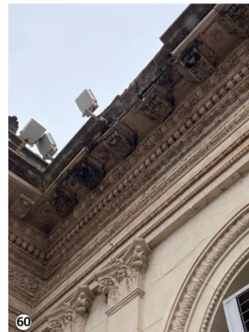
60 Rotura de moldura superior de pared. Inminente riesgo de desprendimiento y caída de ménsulas ornamentales.
