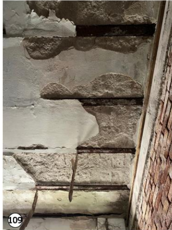
109 Avanzado estado de oxidación ferrosa y decapamiento (pérdida de sección) de los perfiles metálicos que conforman la estructura del subsuelo. Desprendimiento y estado de oxidación del metal desplegado que se encuentra en el cielorraso del subsuelo.
