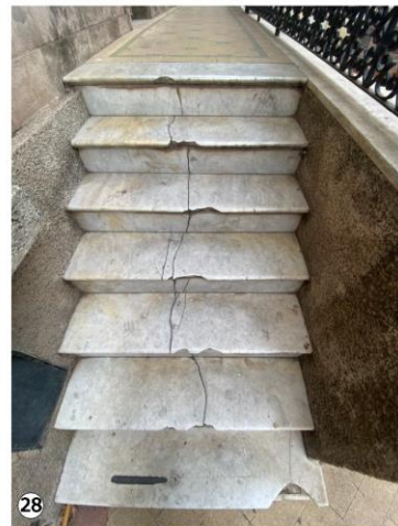
Rotura en ambos tramos de escaleras (huellas y contrahuellas).
