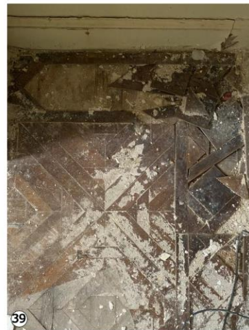
39 Desprendimiento y rotura de piso de madera
