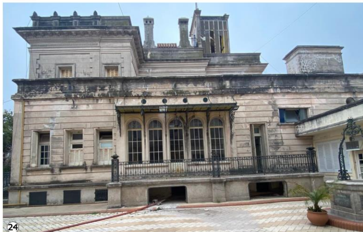
Fachada posterior del palacio (sobre corazón de manzana), en avanzado estado de deterioro: Grietas, surcos, desprendimiento de material, pátina biológica, presencia de costra negra.
