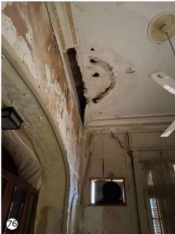
Grieta diagonal en pared: Signi-cativa separación entre tramos de muro. Desprendimiento de material de cielorraso y material de terminación de paredes de la habitación.
