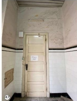
47 Grieta diagonal en esquina superior derecha de puerta.
