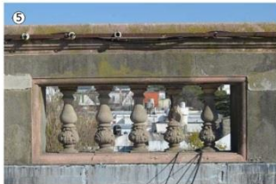
Balaustre en avanzado estado de rotura y desprendimiento de material. Hierros de armadura expuestos.
