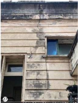
27 Considerable grieta vertical en muro.
