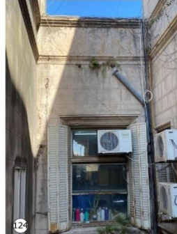
124 Presencia de vegetación invasiva en muro exterior, oxidación de postigones metálicos, erosión de revoque simil piedra.
