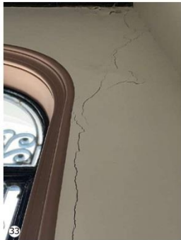
33 Grietas diagonales en muros de hall (Interior del edificio).
