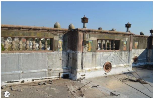
Tramos de la membrana asfáltica (aislación hidrófuga del techo) en estado de rotura, lo que posibilita el ingreso del agua de lluvia hacia el interior de la edificación. Presencia de pátina biológica (musgo, hollín) en muros de parapeto.
