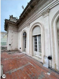
Terraza sobre calle 9 de Julio: Inadecuada impermeabilización del piso produce infiltración del agua de lluvia hacia el interior.
