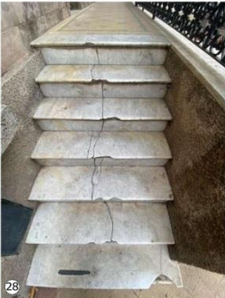
28 Rotura en ambos tramos de escaleras (huellas y contrahuellas).
