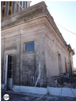
Considerables Grietas Diagonales en muros de terraza con antiguas reparaciones. En ambas fotografías se observa como las grietas continúan activas, dado que las mismas volvieron a abrirse posterior a su reparación.
