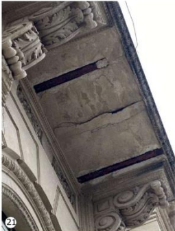
21 Ménsulas de hierro que conforman la estructura de soporte del balcón, en estado de oxidación y en contacto con el agua de lluvia.
