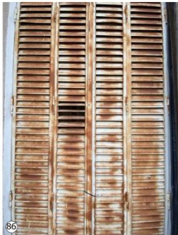
86 Estado de oxidación de postigones metálicos de aberturas con salida a balcón.
