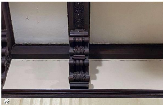
56 Grieta horizontal en encuentro entre cielorraso y tramo superior de muro.
