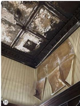
31 Desprendimiento de material de terminación consecuencia de la presencia de humedades en paredes y cielorraso.
