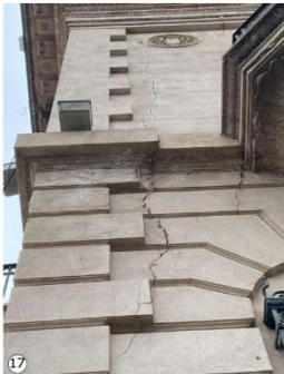
17 Grieta vertical en esquina de muro (sobre calle Echeverría), desde zócalo de planta baja hasta molduras ornamentales de planta alta.
