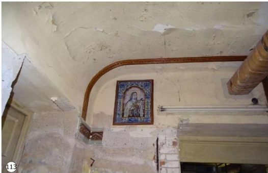
Consecuencia del alto nivel de la capa freática y la constante presencia de agua en el subsuelo, se produce el desprendimiento de material correspondiente a revocos y pinturas, presencia de sales por e-orecencia en muros y delorrasos.
