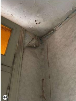
44 Humedad en cielorraso. Desprendimiento de revestimiento de paredes
