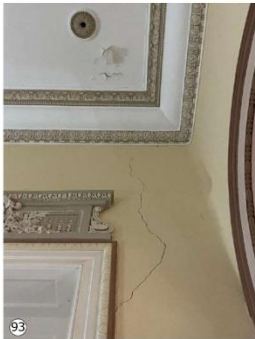
Grietas verticales en paredes perimetrales de circulación central en planta alta.
