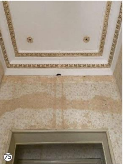
Grieta vertical en molduras de cielorraso.
