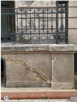
30 Grieta diagonal en zócalo de fachada (muro de contención de escaleras).
