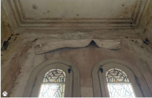
Presencia de sales por e-orecencia, Hongos y avanzado estado de Desprendimiento de material de revestimiento de muros y cielorrasos de salas, consecuencia de la constante in-itración de agua hacia el interior del edificio.
