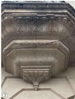
2 Grieta vertical y desprendimiento de material en balcón ornamental, posibilita el ingreso del agua de lluvia hacia el interior del muro.
