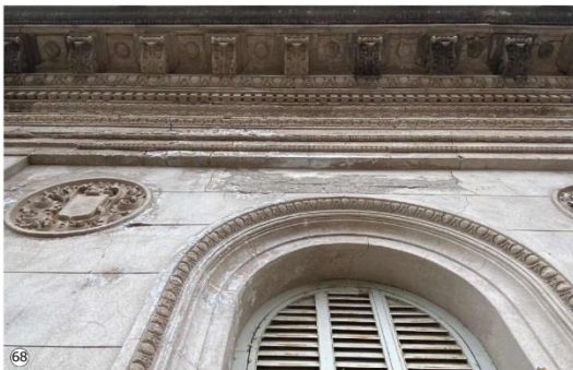
Abundante presencia de sales por e-orecencia en cara exterior de muro. Fisuras y desprendimiento de revoque simil piedra.
