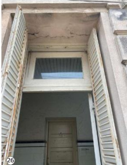
26 Fisuras y desprendimiento de material en dintel de abertura.
