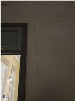
Grieta diagonal junto a puerta de ingreso a habitación (sobre calle Echeverría).
