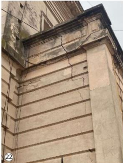
22 Considerable grieta diagonal en tramo superior de muro, posibilita el ingreso del agua de lluvia hacia el interior del muro.
