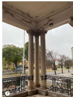
7 Desprendimiento de material correspondiente a revoques y pinturas consecuencia de la infiltración del agua de lluvia desde la terraza.
