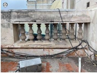
Grieta horizontal en parapeto, con riesgo inminente de caída de material. Erosión y desprendimiento de material en base de apoyo de balastrada.
