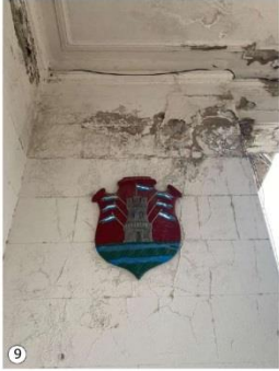
Micro-surcos, sales por e-orescencia y desprendimiento de material en tramo superior de muro.
