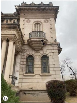
Avanzado estado de deterioro en tramo derecho de fachada principal (Sobre calle 9 de Julio).
