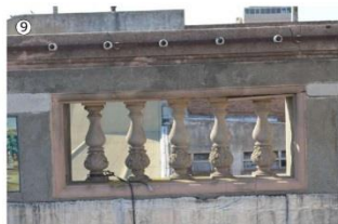
Presencia de -suras en base y tramo superior balaustres (parapeto)
