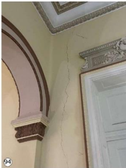
Grietas verticales en paredes perimetrales de circulación central en planta alta.
