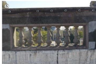
Presencia de -suras en base y tramo superior de balaustres (parapeto).
