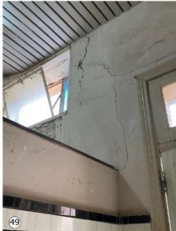
48 Grietas en pasillo hacia cocina de edificio (Planta Baja): Considerables separaciones entre tramos de muro.
