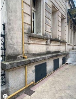
25 Patina biológica y costra negra en molduras, salientes de muro, antepechos de aberturas.
