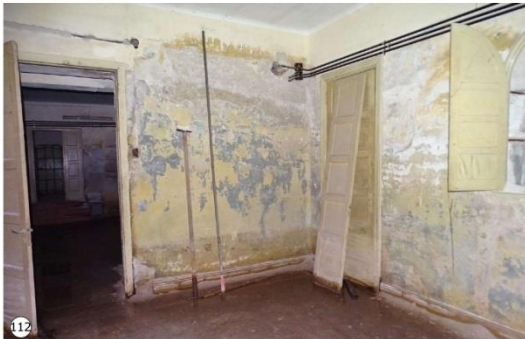
Consecuencia del alto nivel de la capa freática y la constante presencia de agua en el subsuelo, se produce el desprendimiento de material correspondiente a revocos y pinturas, presencia de sales por e-orecencia en muros y delorrasos.
