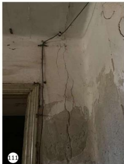
111 Grieta vertical en muro con continuación en cielorraso.
