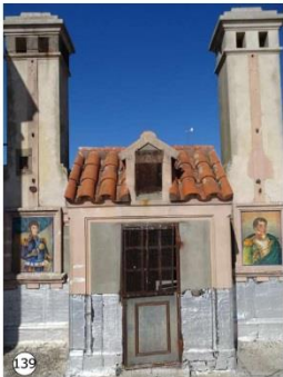
Abundante presencia de guano de aves en tejas coloniales y sobre membrana hidrófuga que protege superficie de cubierta inaccesible.
