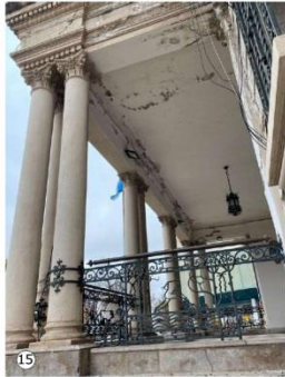
Humedades y desprendimiento de material en cielorraso de ingreso, consecuencia de la falta de impermeabilización de la terraza superior.
