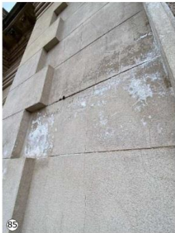
85 Presencia de sales por e-orescencia, consecuencia de la presencia de agua en el interior del muro.
