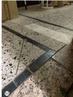
51 Desnivel en piso, entre vanos de ingreso a cocina.
