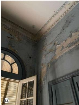
Desprendimiento de material correspondiente a revocos y pinturas de cielorrasos y paredes. Sales por e-orescencia consecuencia de la constante presencia de humedades.
