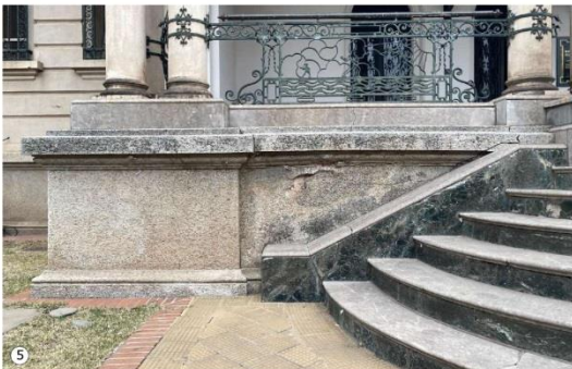
5 Fisuras y desprendimiento de material de terminación en zócalo sobre escalera.
