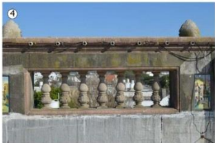
Pátina biológica (musgo, hollín) Presencia de -suras en tramo superior balaustres (parapeto)
