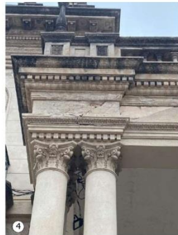
4 Erosión y Grieta diagonal en architrave de entablamento.
