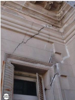
Considerables grietas diagonales sobre puerta de salida a terraza posibilita el ingreso de agua hacia el interior, incrementando el deterioro del muro.
