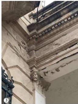
3 Sales por e-orescencia consecuencia de la infiltración del agua de lluvia y desprendimiento de material en encuentro de muros.
