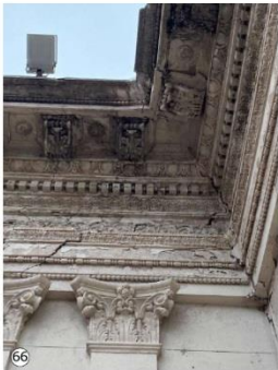
Erosión y desprendimiento de molduras ornamentales. Riesgo de caída de ménsulas bajo cornisa.
