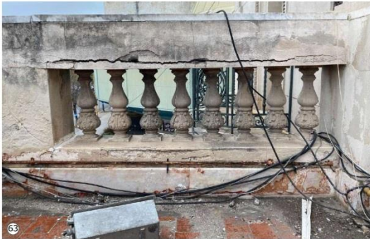
Grieta horizontal en tramo superior de balaustrada. Erosión en muros produce desprendimiento de revoques y pinturas.
