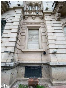
18 Abundante presencia de guano de ave en vereda perimetral. Fisuras diagonales en muro.
