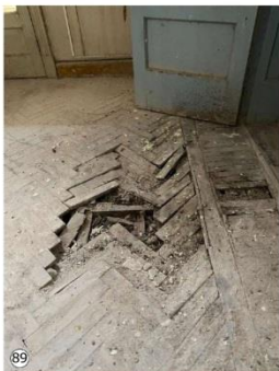
89 Rotura y desprendimiento en piso de madera. Presencia de suciedades y guano de palomas.
