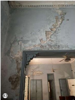
Desprendimiento de material correspondiente a revocos y pinturas de cielorrasos y paredes. Sales por e-orescencia consecuencia de la constante presencia de humedades.
