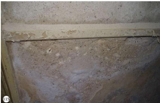
Abundante presencia de sales por e-orecencia en revocos y pinturas de muros.
