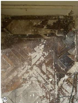
39 Desprendimiento y rotura de piso de madera
