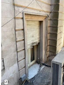
123 Rotura y deterioro de persiana de madera.
