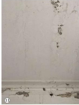
Fisuras en cielorraso de ingreso. Presencia de humedades por in-iltración de agua desde terraza.
