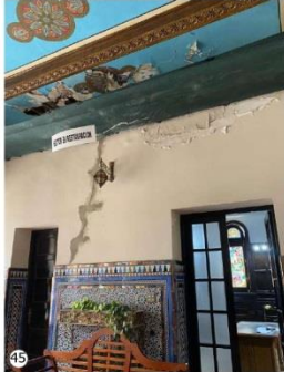
45 Grieta diagonal anteriormente reparada. Presencia de humedades entre cielorraso y tramo superior de pared.
