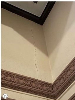
35 Grieta diagonal en tramo superior de muro interior.
