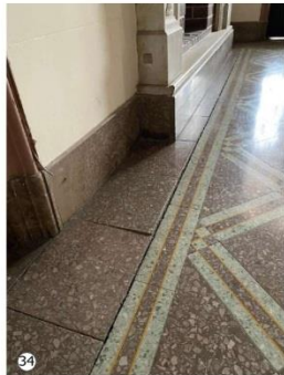
34 Desnivel en piso de hall de ingreso, produce el desprendimiento de mosaicos graníticos.
