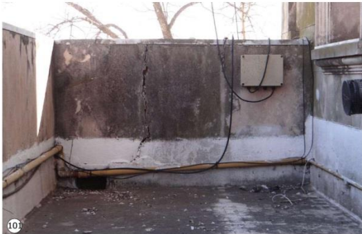
Grieta vertical en muro bajo de terraza accesible
