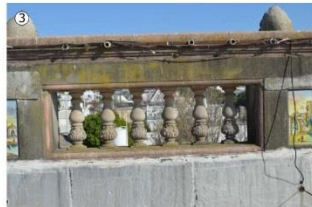
Pátina biológica (musgo, hollín) Presencia de -suras en tapa de parapeto.
