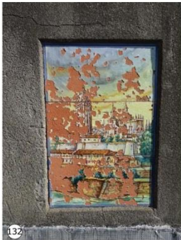
132 Mayólica ornamental en muro de parapeto en estado de deterioro.
