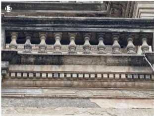
Presencia de pátina biológica en tramo de balastrada (hollín, costra negra). Erosión y desprendimiento de material en base de apoyo de balaustres.
