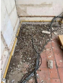
Terraza sobre calle 9 de Julio: Inadecuada impermeabilización del piso produce infiltración del agua de lluvia hacia el interior.
