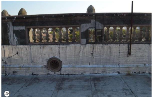
134 Tramos de muros de parapeto afectados por patina biológica (musgo, hollín). Presencia de grietas y fisuras en muro.
