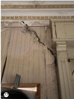
Grieta diagonal en pared: Signi-cativa separación entre tramos de muro. Desprendimiento de material de cielorraso y material de terminación de paredes de la habitación.
