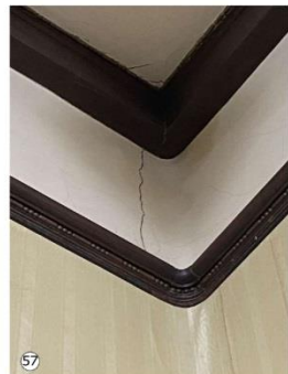
57 Grieta vertical en esquina superior de salón.
