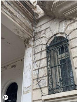
Abundante presencia de sales por e-orescencia, Fisuras y desprendimiento de material en muro.
