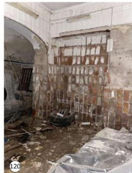
Mobiliario en considerable estado de deterioro, erosión y eflorescencias en muros/cielorrasos. Abundante presencia de suciedades en piso.
