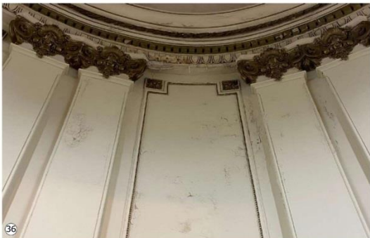
36 Deterioro de molduras ornamentales en muro curvo de sala. Microsuras y desprendimiento de material de terminación en pared (revoques y pinturas)
