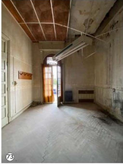
Presencia de sales por e-orecencia, Hongos y avanzado estado de Desprendimiento de material de revestimiento de muros y cielorrasos de salas, consecuencia de la constante in-itración de agua hacia el interior del edificio.
