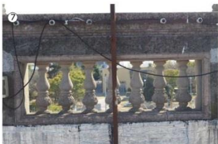
Grieta vertical en balaustre central de tramo posibilita el ingreso del agua de lluvia hacia el interior de la pieza.
