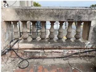
Grieta vertical en balaustres posibilita el ingreso del agua de lluvia hacia el interior, aumentando el estado de deterioro de las piezas ornamentales. Grieta horizontal en parapeto, con riesgo inminente de caída de material.
