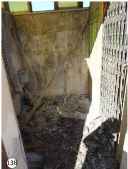
Abundante guano de ave afecta y deteriora el interior del bloque cubierto de acceso a la azotea.
