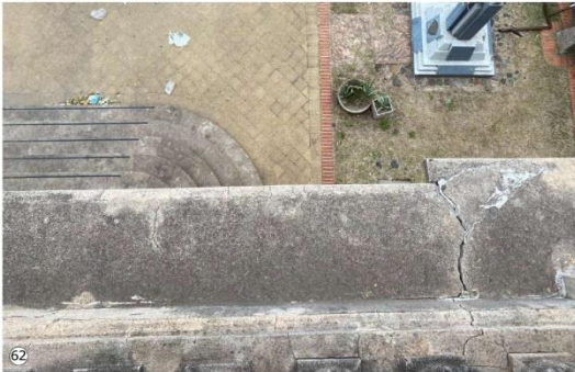
Tapa superior de cornisa: Rotura y presencia de fisuras posibilitan el ingreso del agua de lluvia al interior de la estructura.
