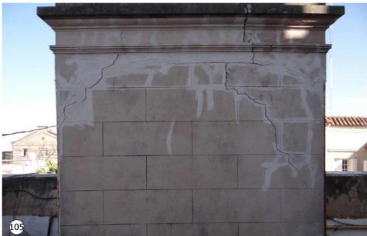
Considerables Grietas Diagonales en muros de terraza con antiguas reparaciones. En ambas fotografías se observa como las grietas continúan activas, dado que las mismas volvieron a abrirse posterior a su reparación.
