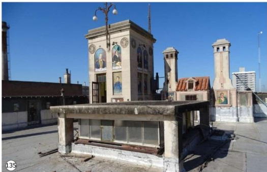
135 Presencia de guano de aves y elementos ajenos a la cubierta como perfiles, cableado suelto, madera, retazos de ladrillos, pueden ocasionar el deterioro y/o rotura de la membrana hidrófuga.
