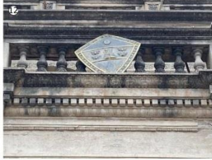
Presencia de pátina biológica en tramo de balastrada (hollín, costra negra).
