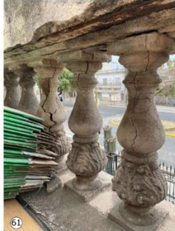
Rotura y desprendimiento de balaustres: Riesgo de caída de material sobre el ingreso al edificio.
