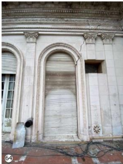
Grietas diagonales en muros de considerable separación.
