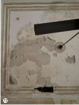
Presencia de sales por e-orecencia, Hongos y avanzado estado de Desprendimiento de material de revestimiento de muros y cielorrasos de salas, consecuencia de la constante in-itración de agua hacia el interior del edificio.
