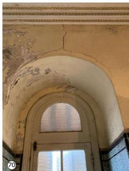
Grieta en arco de muro que rodea la abertura en baño de planta alta.
