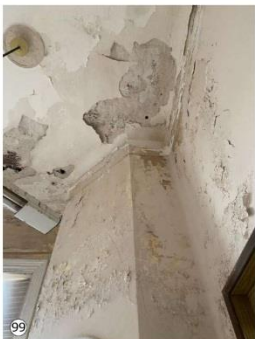
Considerable estado de desprendimiento de material de paredes y cielorraso.
