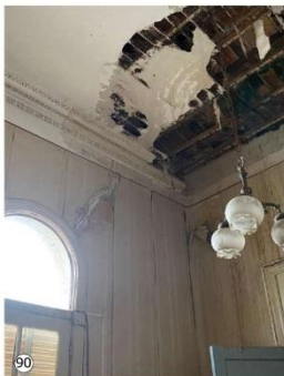
90 Grieta diagonal en tramo superior de abertura. Desprendimiento de cielorraso. Pátina biológica (Hongos) en ladrillos de techo.
