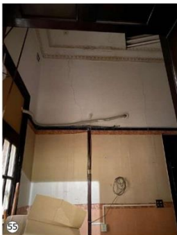
55 Presencia de grietas verticales en muro.
