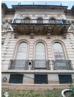
19 Cara inferior de balcón: Estado de corrosión de las ménsulas de hierro que se encuentran expuestas.
