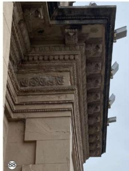
88 Fisuras en muro y desprendimiento de molduras ornamentales bajo cornisa.
