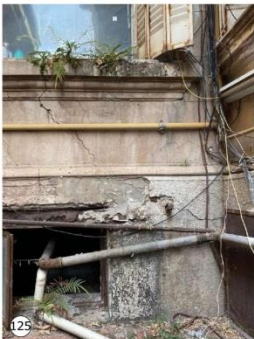
125 Grieta diagonal en tramo inferior de ventana de cocina (Planta Baja), posibilita el ingreso del agua de lluvia hacia el interior de la edificación. Avanzado y considerable estado de oxidación ferrosa de per-1 metálico con pérdida de sección estructural.
