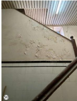
50 Desprendimiento de material en pared lateral de escalera.
