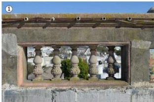
Tramo de balaustre con presencia de pátina biológica (musgo, hollín) Presencia de -suras en tramo superior balaustres (parapeto)
