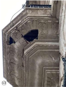
Considerable rotura con faltante de material en ornamentación de balcón.
