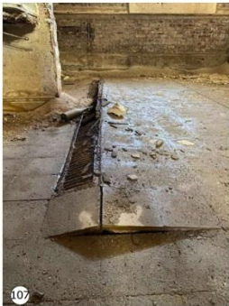
107 Rotura y desprendimiento de material de terminación en piso en tramo de canaleta de desagüe.
