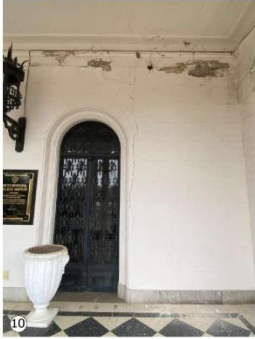
Grieta vertical en lateral derecho de abertura. Desprendimiento de material en tramo superior de muro.
