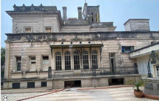
24 Fachada posterior del palacio (sobre corazón de manzana), en avanzado estado de deterioro: Grietas, surcos, desprendimiento de material, patina biológica, presencia de costra negra.
