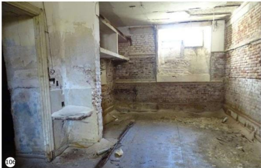
106 Consecuencia del alto nivel de la capa freática y la constante presencia de agua en el subsuelo, se produce el desprendimiento de material correspondiente a revoques y pinturas, estado de oxidación de los fierros que conforman la estructura, presencia de sales por eflorescencia en muros.
