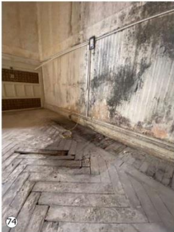
Hongos en muro, y piso de madera de habitación en planta alta en estado de rotura.
