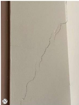
32 Grietas diagonales en muros de hall (Interior del edificio).
