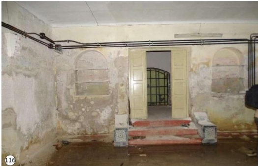
Permanente presencia de agua en superficie de piso, consecuencia del alto nivel de napas freáticas. Desprendimiento de material correspondiente a revoques y pinturas de muros y cielorrasos. Abundante presencia de sales por eflorescencia.
