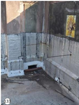
133 Presencia de suciedades junto a la boca de desagüe pluvial, lo que ocasiona su obstrucción.
