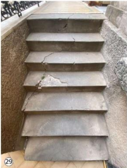
29 Rotura en ambos tramos de escaleras (huellas y contrahuellas).
