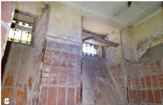
Presencia de sales por e-orecencia en ladrillos de revestimiento. Estado de oxidación en per-les metálicos.
