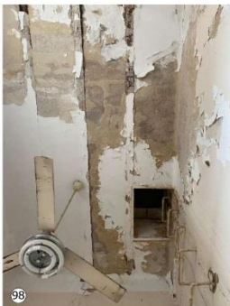
Estructura metálica de cielorraso expuesta y en estado de oxidación. Desprendimiento de material de revestimiento.
