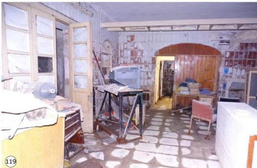
Presencia de humedades en muros y pisos, consecuencia de la constante presencia de agua produce el deterioro de aberturas de madera, materiales de revestimiento, desprendimiento y erosión de revoques.
