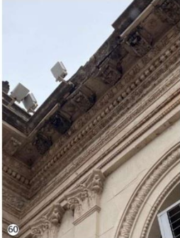
Rotura de moldura superior de pared. Inminente riesgo de desprendimiento y caída de ménsulas ornamentales.
