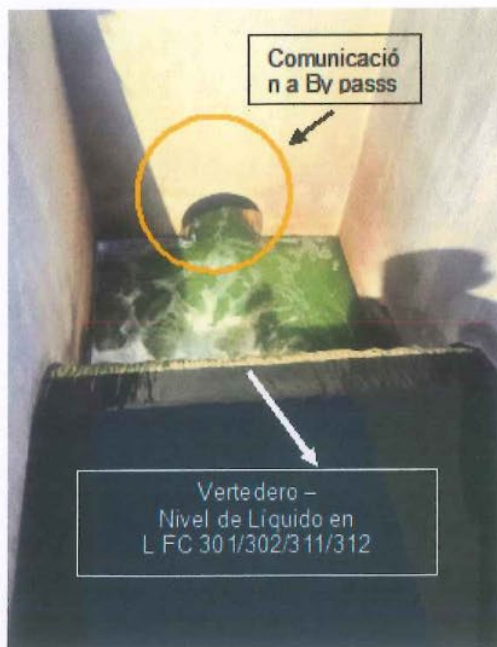
Imagen 14: Cámara vertedero - Total 2 - Una para LFC-301/302 y otra para LFC - 311/312
