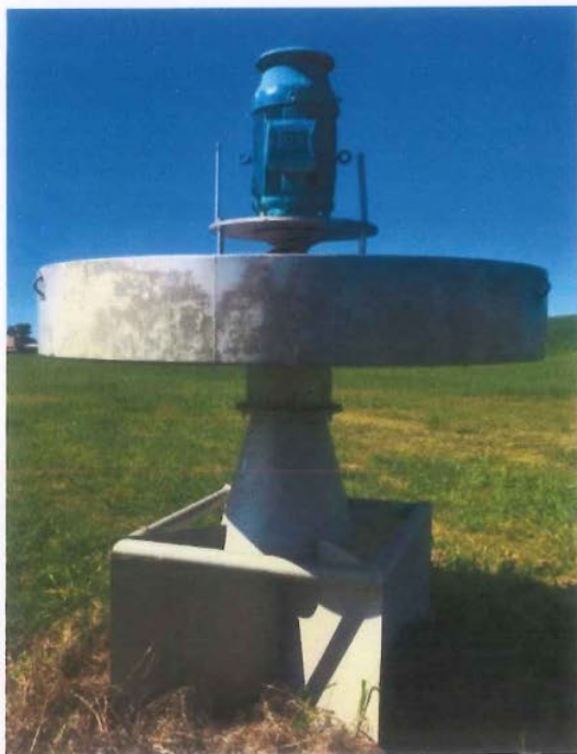
Imagen 11: Aireador superficial – Foto: equipo de 22 KW
