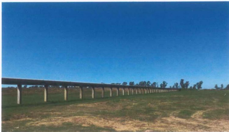
Imagen 10: Cañería de alimentación a sistema original de Lagunas – PRFV – 600 mm diám.
