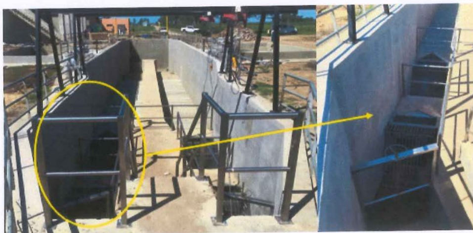
Imagen 2: Posición rejas Gruesas y Finas - Canal Izquierdo
