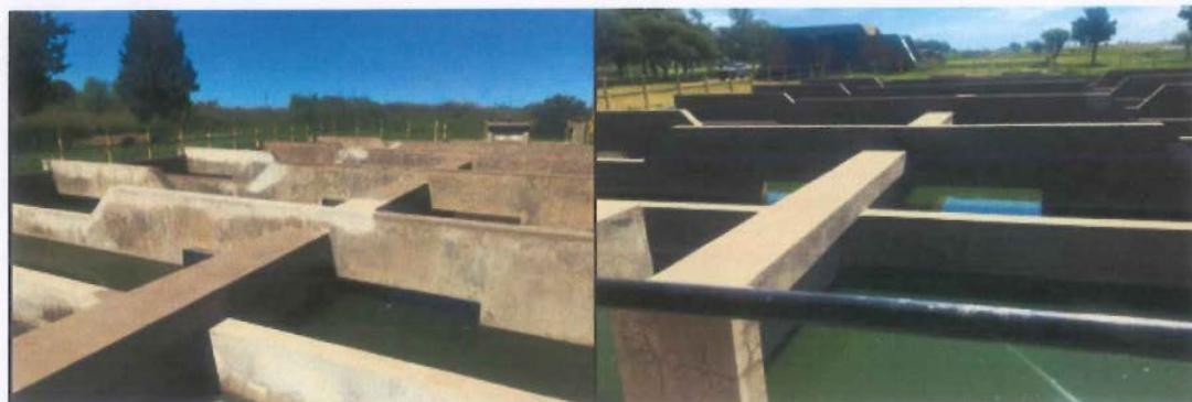
Imagen 8: Cámara de contacto
