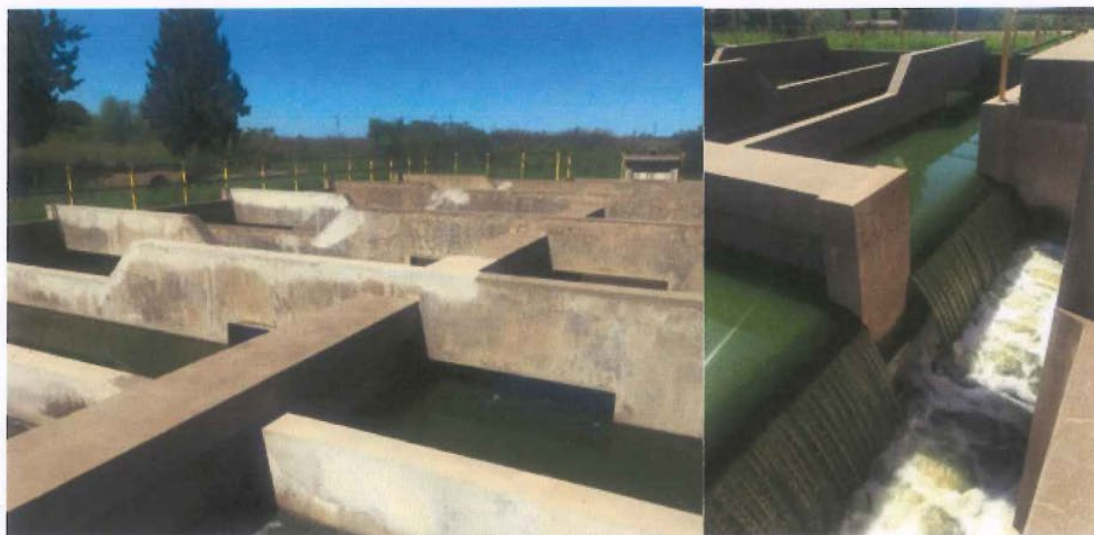
Imagen 17: Cámara de Contacto
