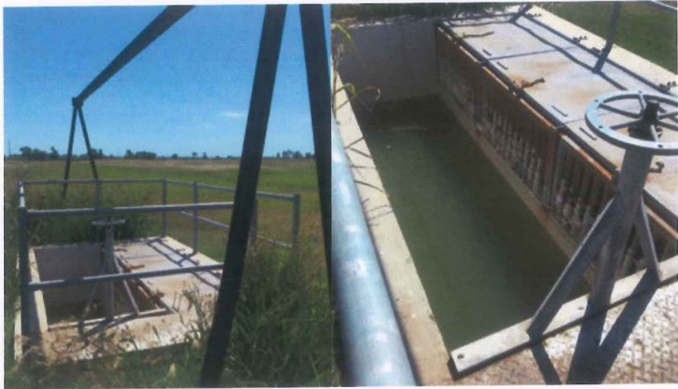
Imagen 1: Cámara Equipartidora de ingreso
